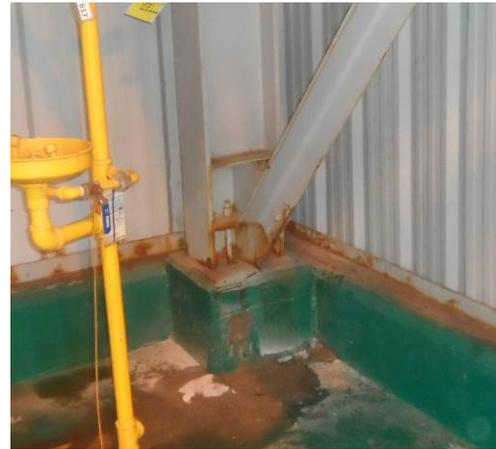
b) Pedestal de columna metálica
