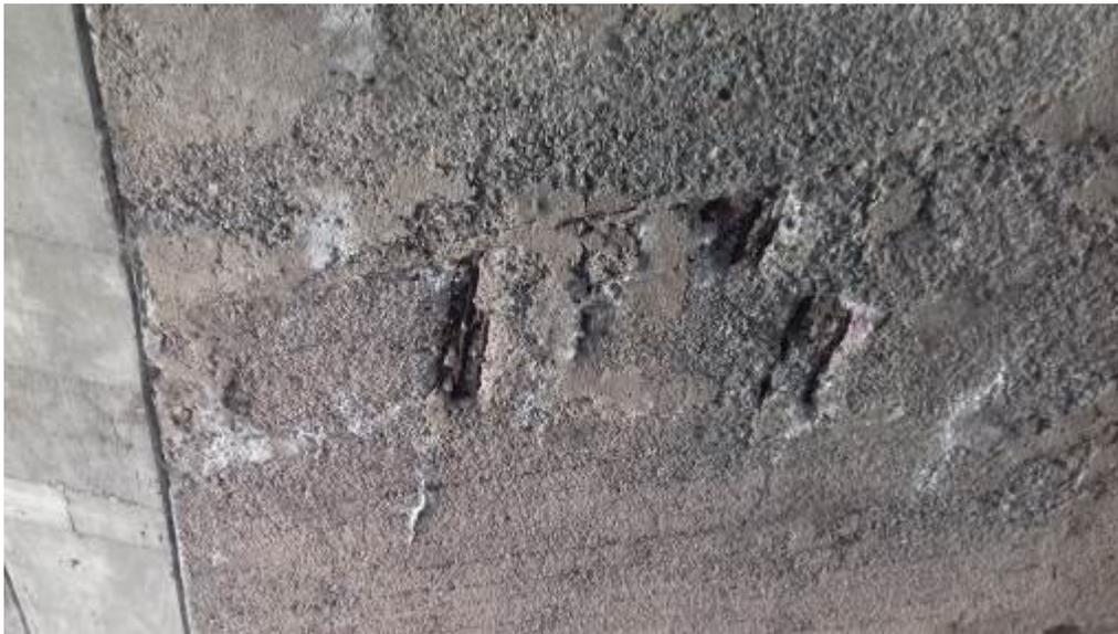
Figura 13. Degradación del concreto por corrosión de armaduras
