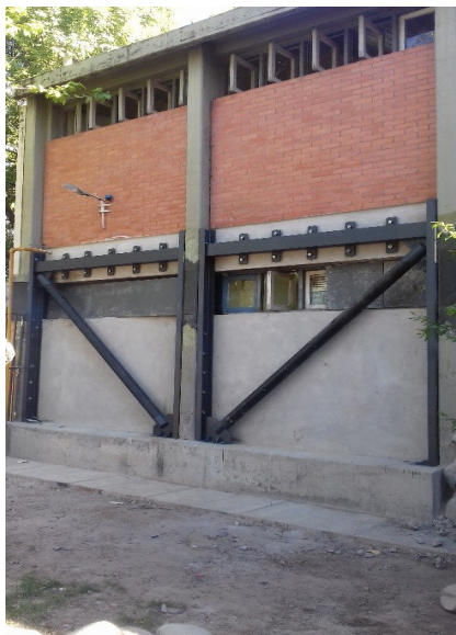
Figura 9 (e). Sistema de refuerzo con riostras (riostroas instaladas)
