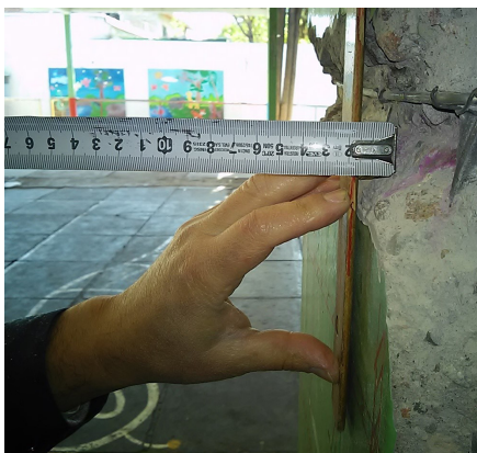
Figura 3. Ensayo de carbonatación
