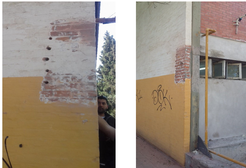
Figura 8 (b). Sistema de refuerzo con FRP (limpieza del sustrato en mampostería)
