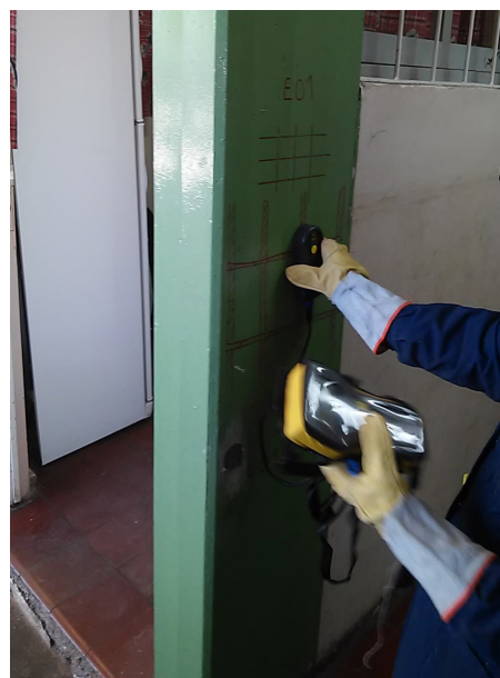
Figura 5. Ensayo de detección de armadura con pachómetro
