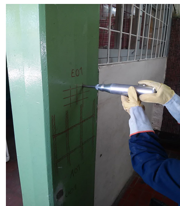
Figura 2. Ensayo de esclerometría
