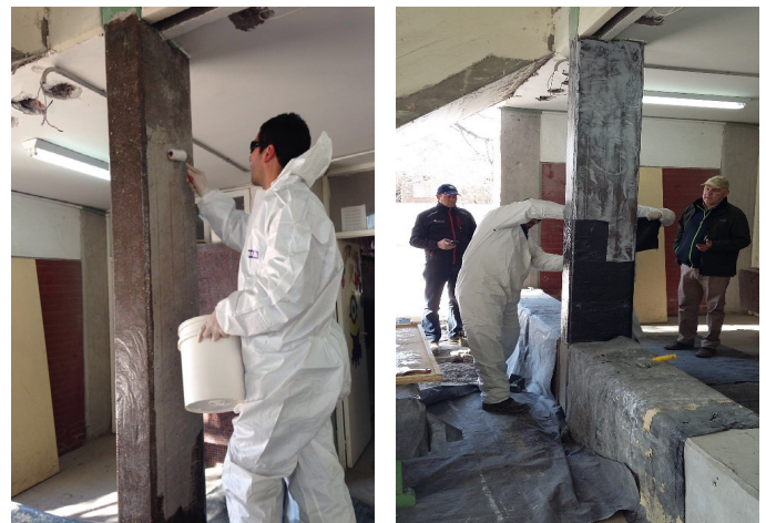
Figura 8 (e). Sistema de refuerzo con FRP (colocación del sistema FRP + adhesivo)
