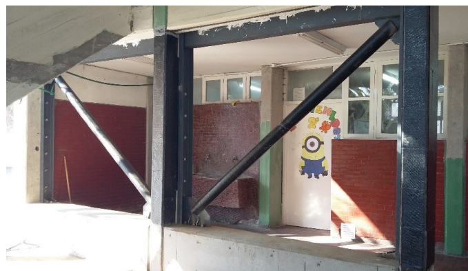
Figura 9 (f). Sistema de refuerzo con riostras (riostroas instaladas)
