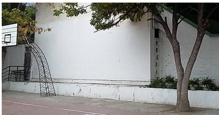
Figura 1 (b). Edificio escolar (muro perimetral este)
