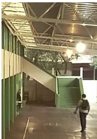
Figura 1 (c). Edificio escolar (escalera)
