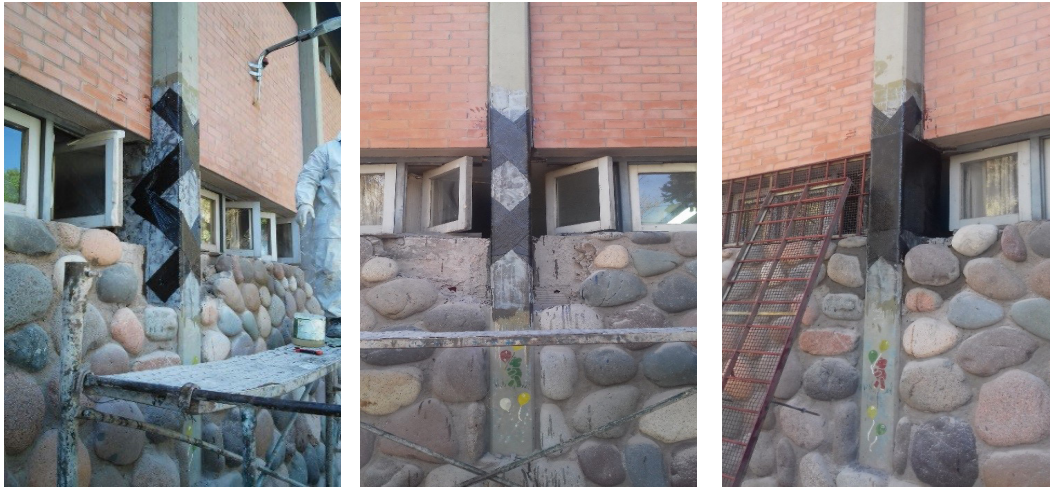
Figura 8 (g). Sistema de refuerzo con FRP (columnas cortas de fachada)
