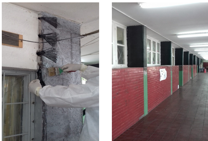
Figura 8 (f). Sistema de refuerzo con FRP (colocación de conectores)
