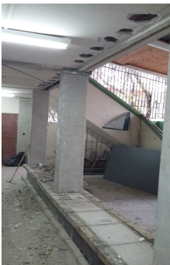
Figura 9 (c). Sistema de refuerzo con riostras (preparación de anclajes en losa)
