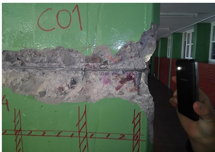
Figura 6. Estudio de verificación de armadura
