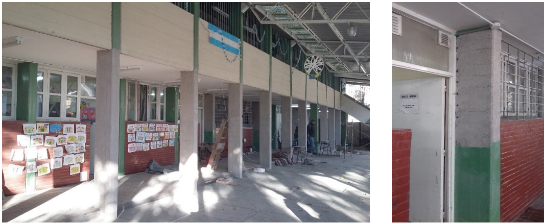
Figura 8 (a). Sistema de refuerzo con FRP (limpieza del sustrato en concreto reforzado)
