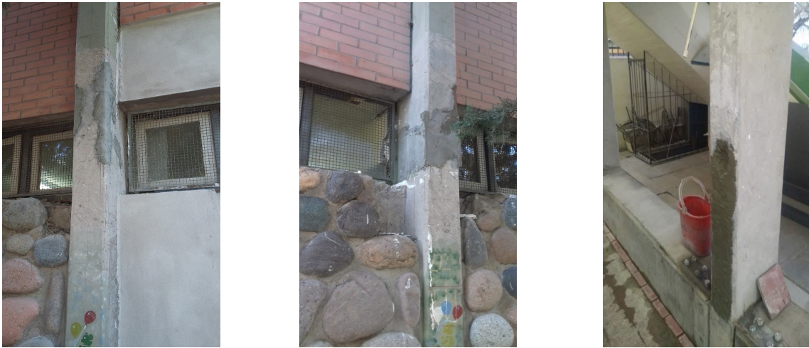
Figura 8 (c). Sistema de refuerzo con FRP (reparación del sustrato dañado)
